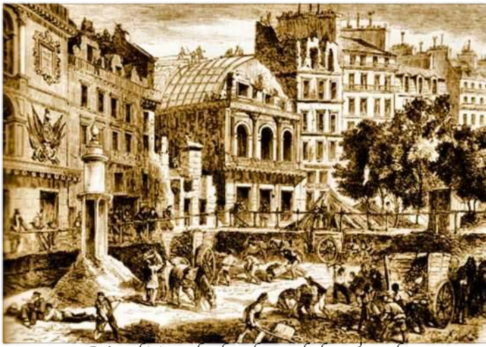
Démolition du boulevard du Temple
